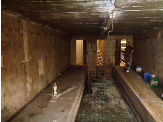
Maçonnerie pour une salle de traite en épis.
